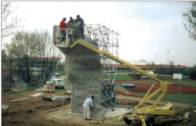
Der 1. Bauabschnitt ist fast vollendet
